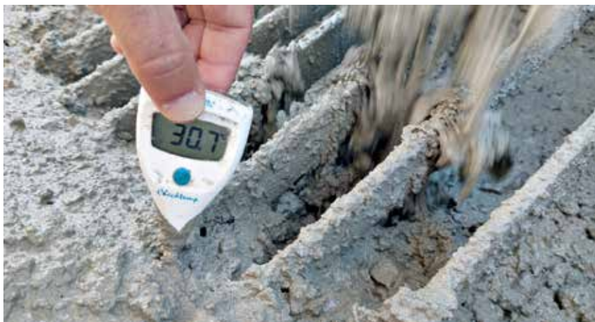
Μέτρηση θερμοκρασίας νωπού σκυροδέματος
