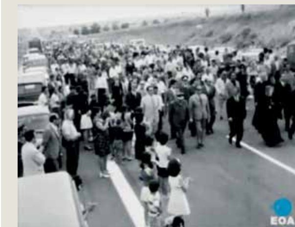
Τα εγκαίνια του τμήματος Βαθύλακκου - Ευζώνων της Εθνικής Οδού 1 τα οποία τελέστηκαν στον Βαθύλακκο το Σάββατο 28 Ιουλίου 1973 (Εθνικό Οπτικοακουστικό Αρχείο)
