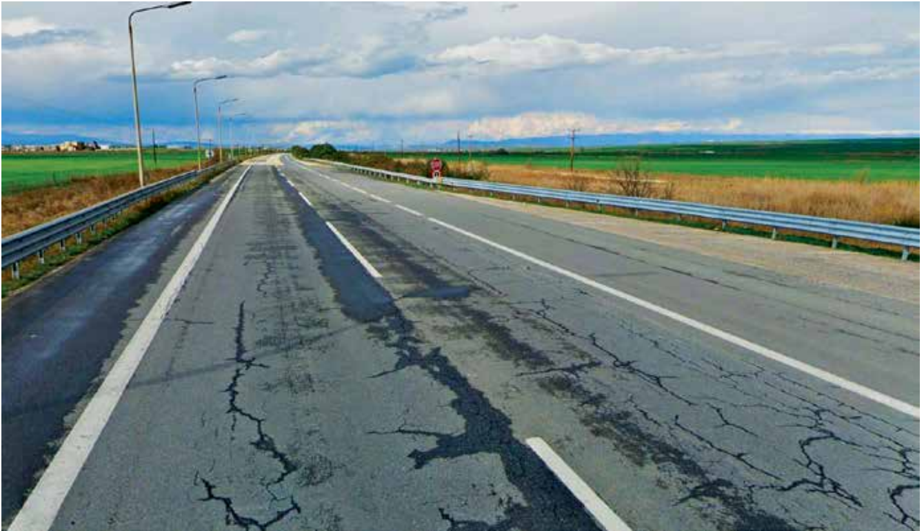
Η Εθνική Οδός 1 (Τμήμα: Ευζώνων - Βαθυλάκκου) κοντά στον Σιδηροδρομικό Σταθμό Άσπρου (Πρόγραμμα Οδεύσεως)
